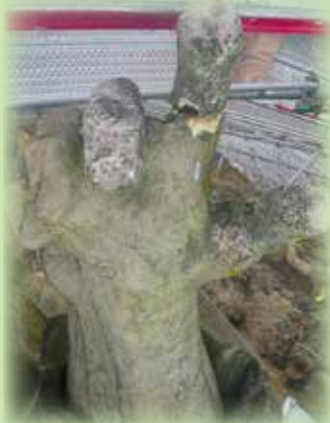
Verwitterungsschäden – Detailaufnahmen
